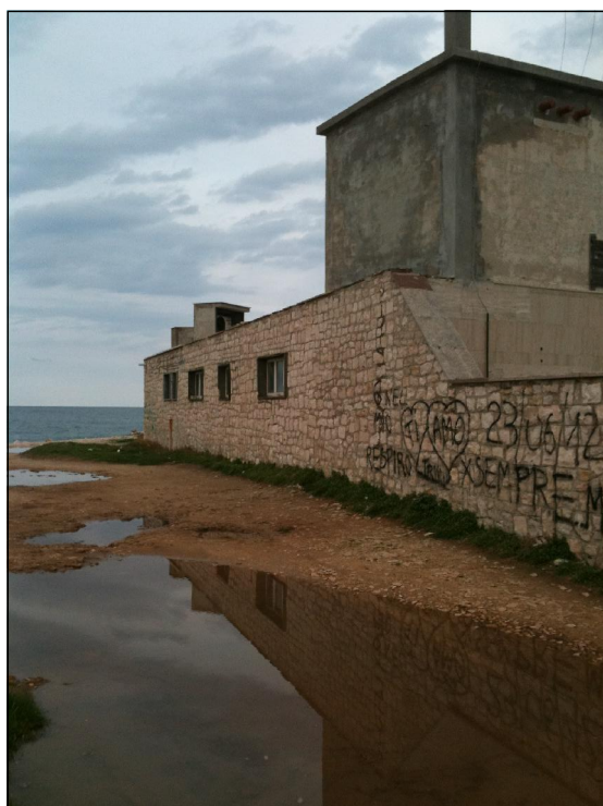
Fotografia n.2: Prospetto laterale esterno fabbricato uffici "a"
