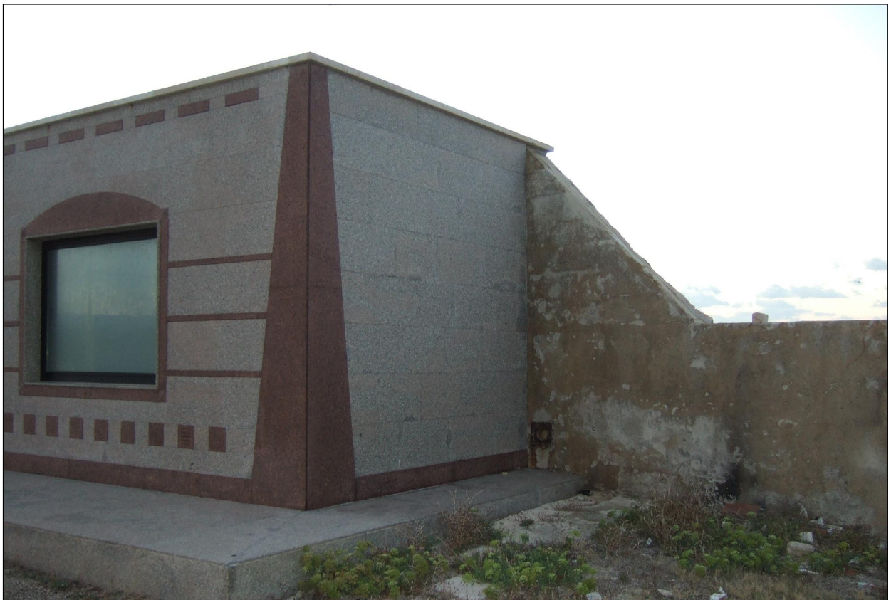
Fotografia n.6: Prospetto posteriore interno fabbricato uffici "a"
