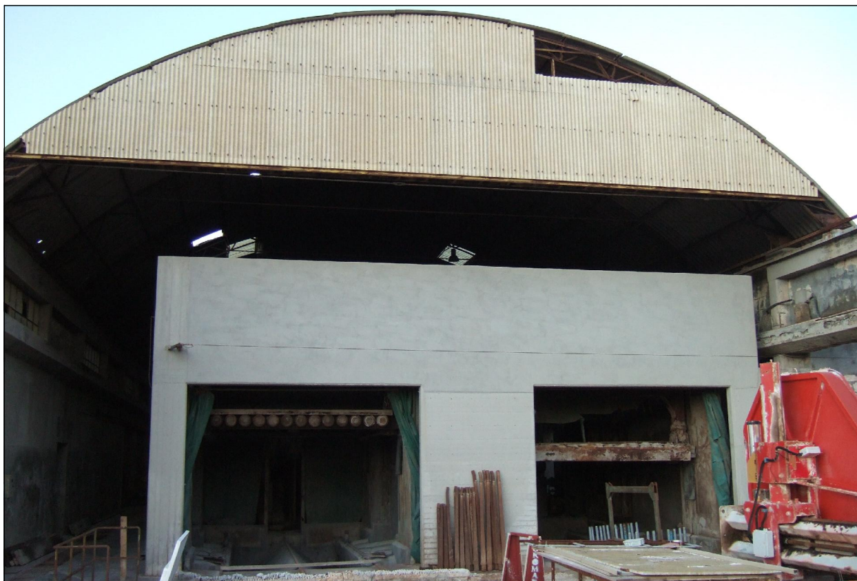
Fotografia n.8: Prospetto principale capannone "c"
