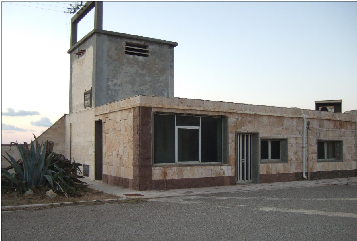
Fotografia n.4: Prospetto interno fabbricato uffici "a"
