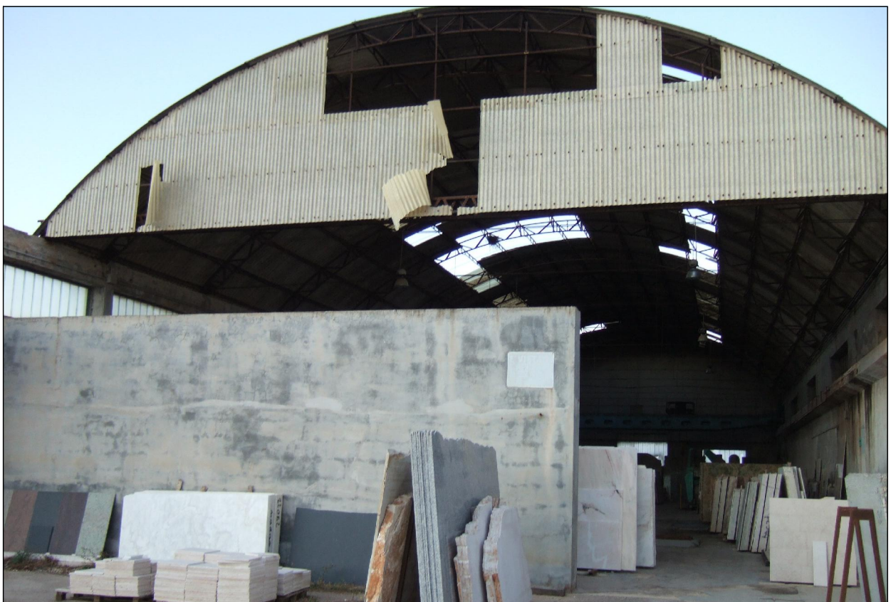
Fotografia n.7: Prospetto principale capannone "b"
