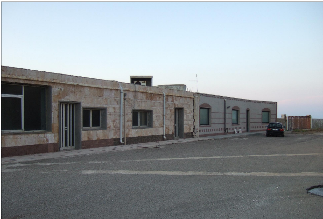
Fotografia n.5: Prospetto laterale interno fabbricato uffici "a"
