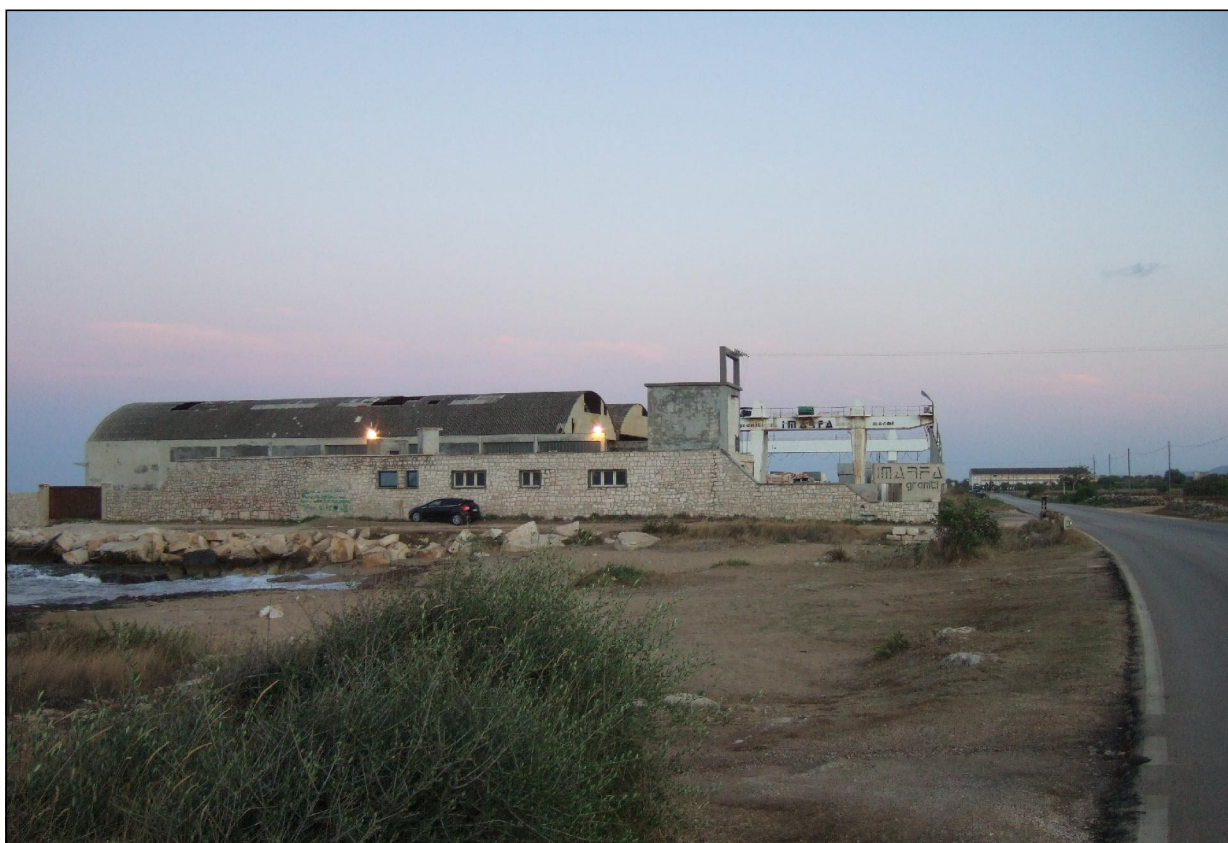
Fotografia n.1: Vista fotografica di insieme da nord ovest
