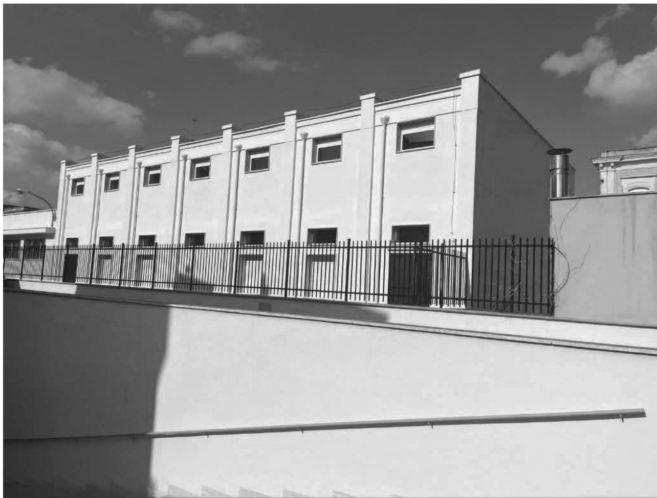
Figura 40 - corpo palestra post intervento
