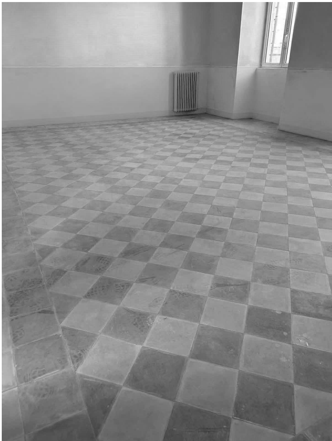
Figura 20 - aula post intervento
