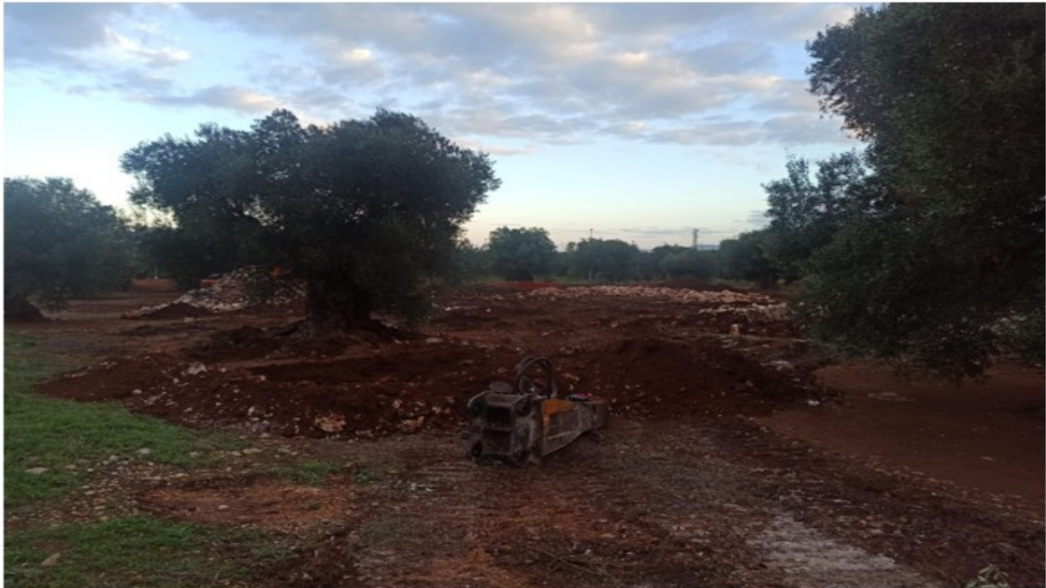
Figura 1- fase di scavo
