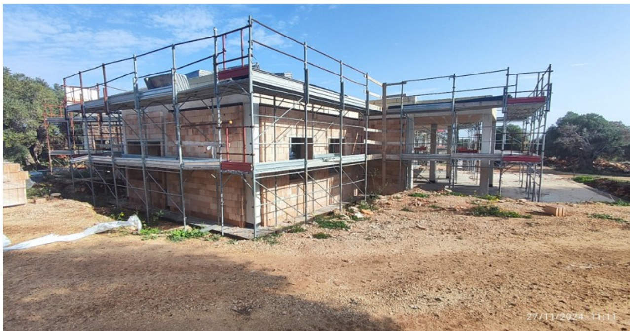
Figura 7 - struttura al grezzo
