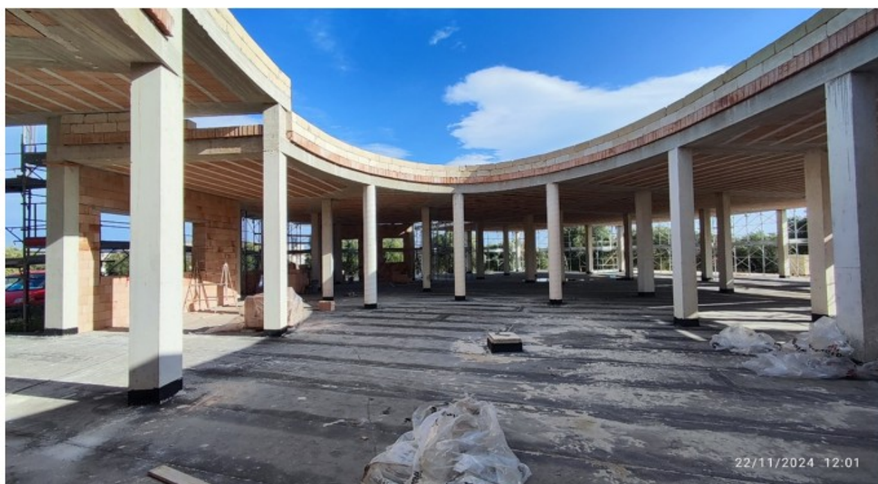
Figura 6 - struttura al grezzo
