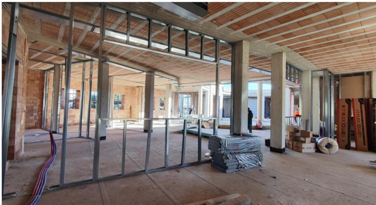
Figura 9 - realizzazione tramezzature interne
