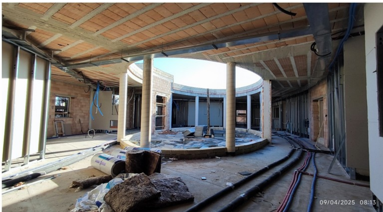
Figura 10 - posa degli impianti
