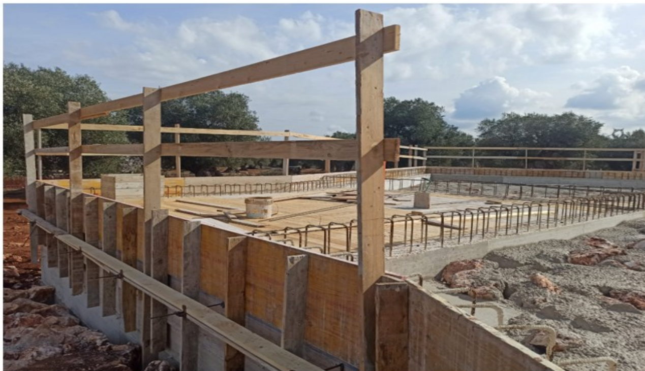
Figura 5 - armatura travi continue
