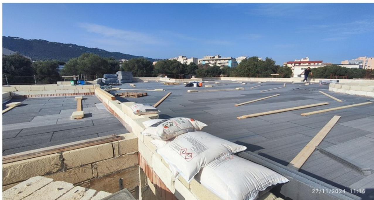
Figura 8 - isolamento lastrico solare
