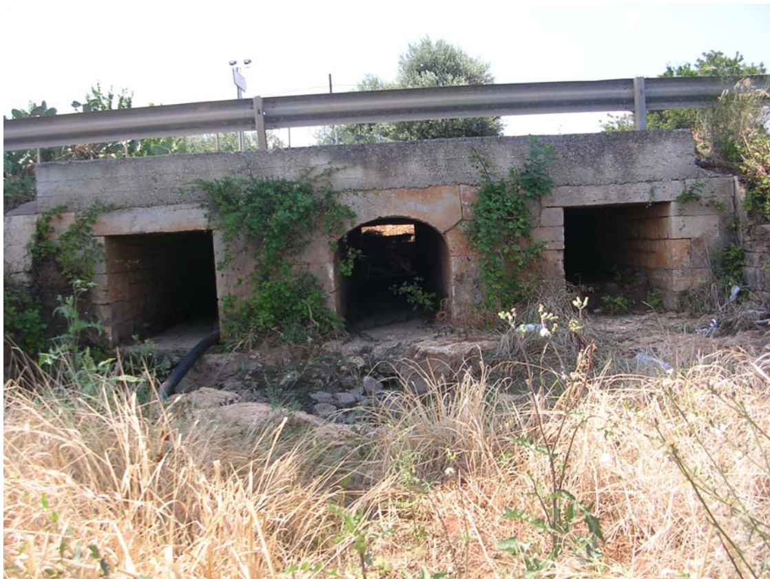
Foto 2 – Sbarramento longitudinale di un canale.
