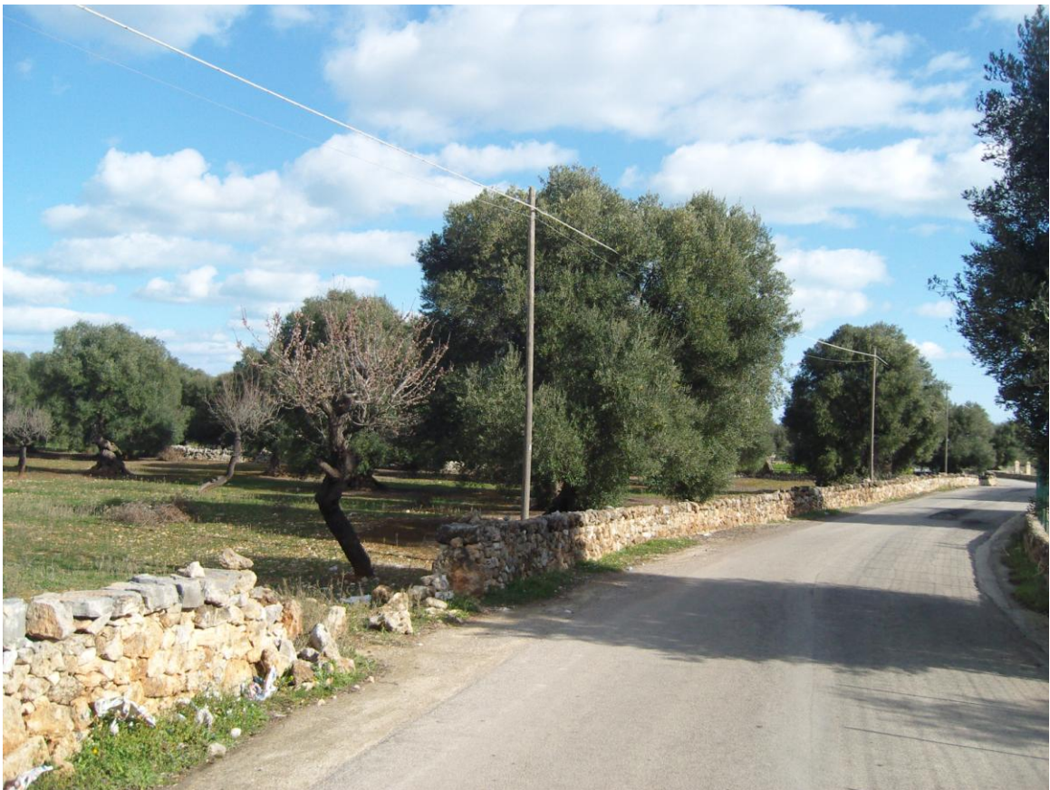
Fotografia n. 3 - Vista da Via Scafati direzione monti-mare tratto intermedio
