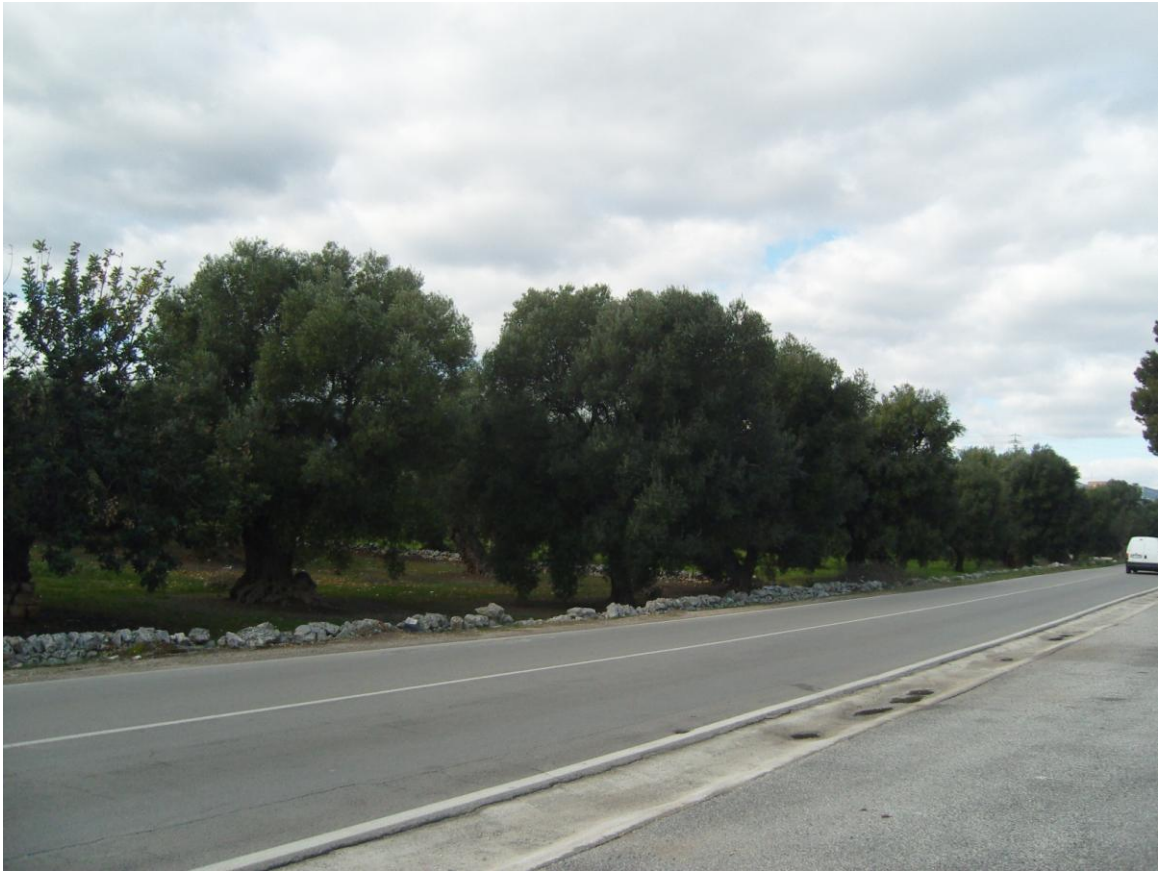
Fotografia n. 8 - Vista dalla strada comunale Fasano-Pezze di Greco tratto intermedio
