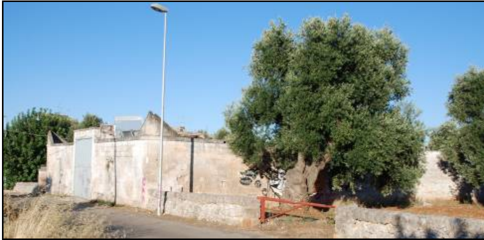
Il manufatto esistente oggetto di recupero e via Ferrini
