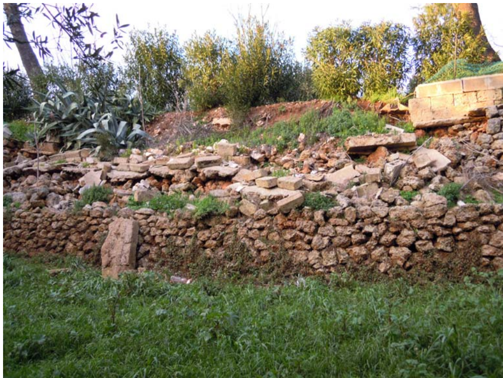
Foto 3: Sbarramento dell'impluvio in sinistra idraulica alla zona di studio
