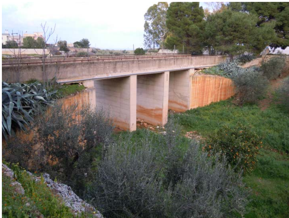
Foto 5: Attraversamento strada comunale via delle Grotte
