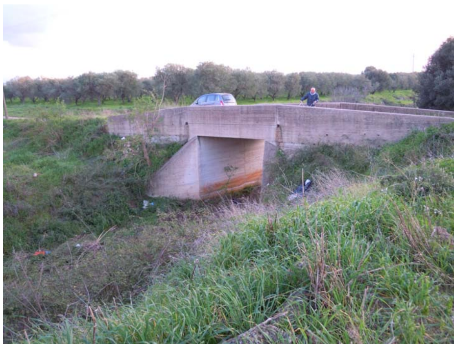
Foto 6: Attraversamento strada comunale via delle Poste
