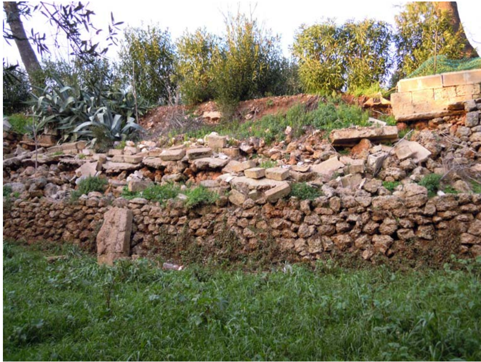
Foto 13: Sbarramento dell'impluvio in sinistra idraulica alla zona di studio
