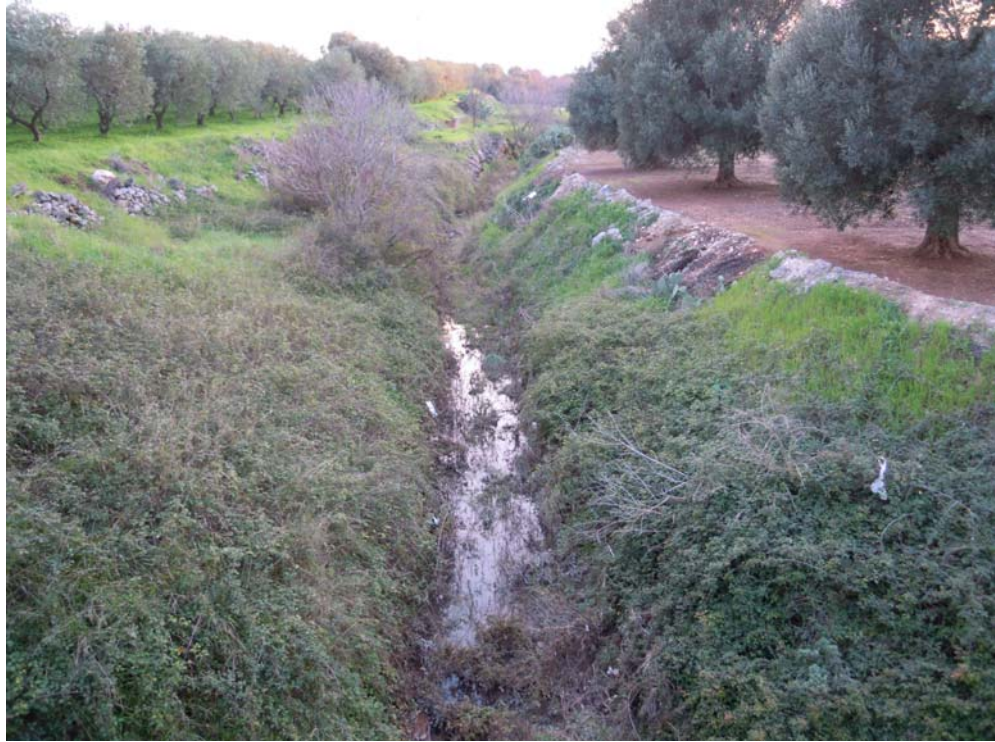
Foto 7: Lama principale vista da valle verso monte in corrispondenza delle strada comunale via delle Poste
