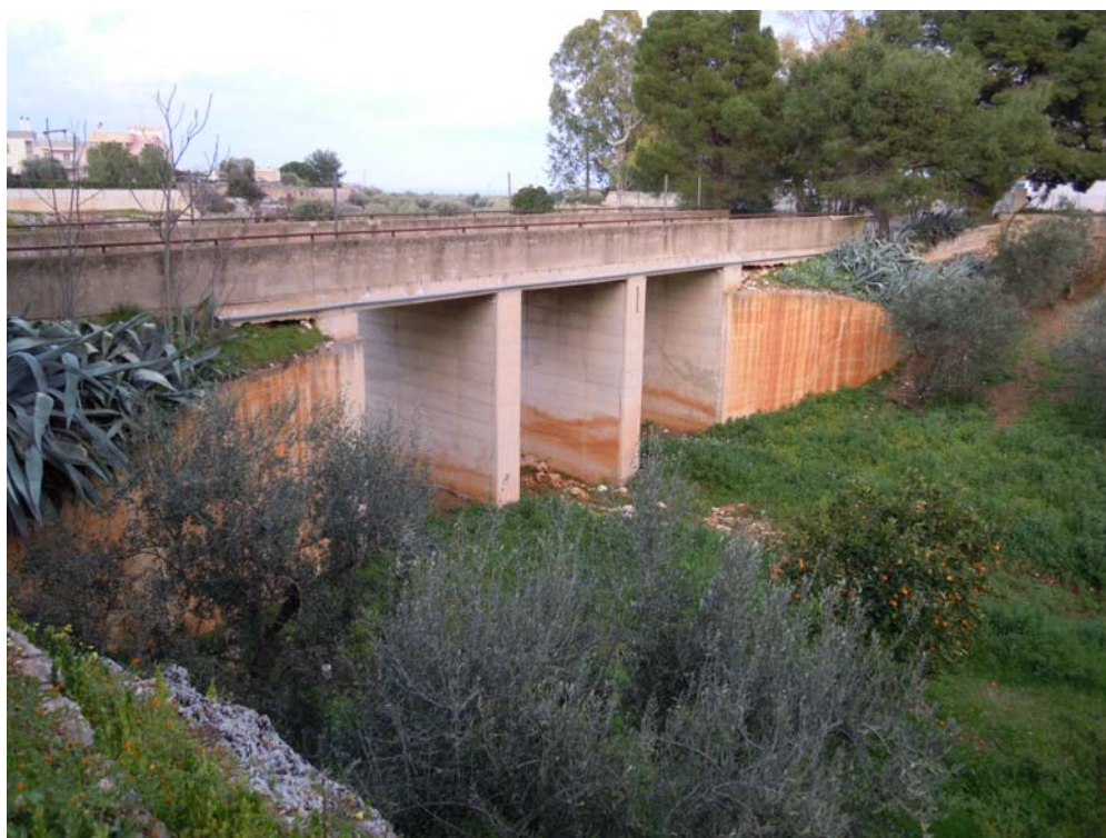
Foto 6: Attraversamento strada comunale via delle Grotte
