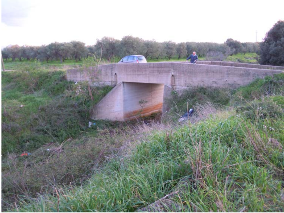
Foto 9: Attraversamento strada comunale via delle Poste
