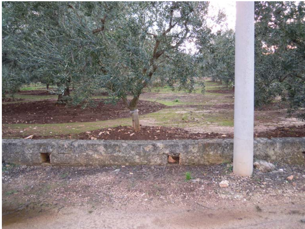
Foto 10: vista verso monte dell'impluvio in sinistra idraulica
