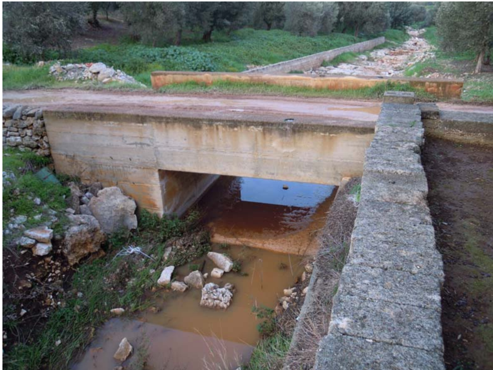
Foto 3: Attraversamento strada vicinale
