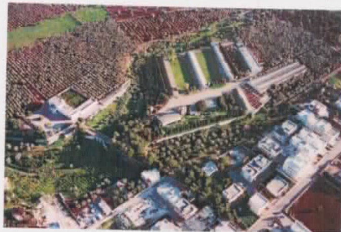
Figura 3c – Individuazione dell'area oggetto di intervento con la situazione precedente in planimetria e in foto (pre-demolizione degli opifici dismessi) e quella di progetto.
