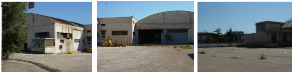
Foto dello stato di fatto
