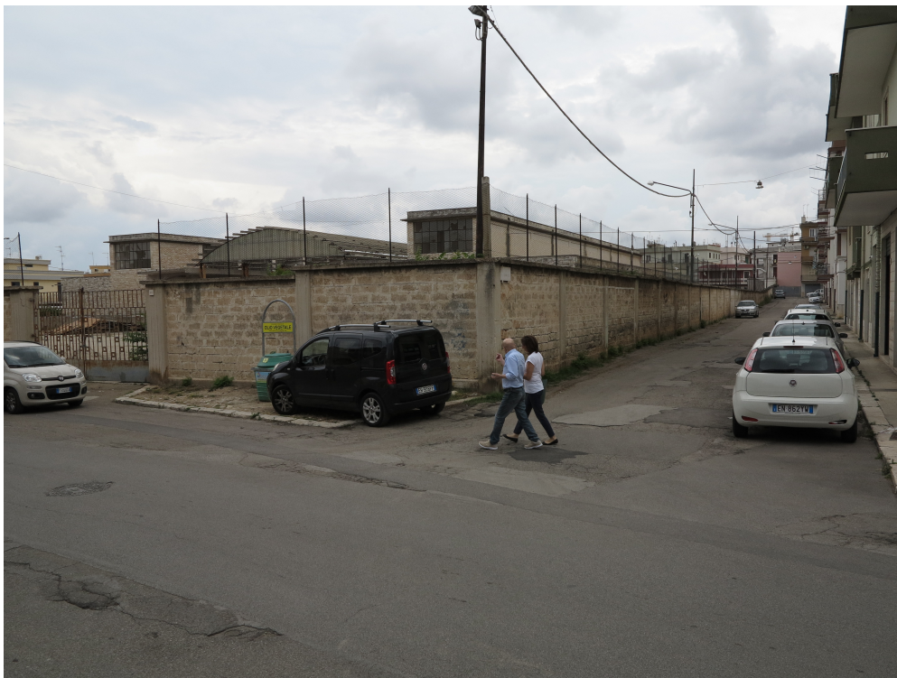
8. PREIMETRO STRADALE EX MERCATO ORTOFRUTTICOLO
